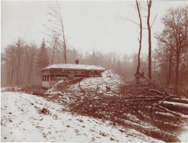
1915 : Le Largin (commune de Bonfol), blockhaus Nord en construction.
