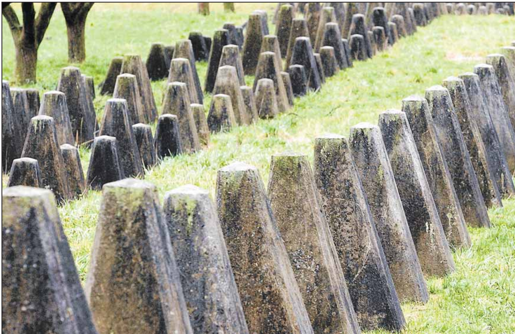
Les fameux «Toblerones» (lignes antichars) figurent parmi les milliers d'ouvrages militaires tombés en désuétude suite à la réforme Armée 95. KEYSTONE
